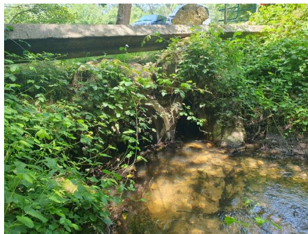
Vue du passage busé depuis l'amont à l'étiage (20/06/2025)
