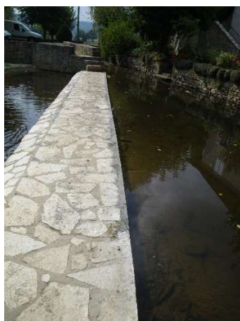
Exemple de seuils en pierres maçonnées.
