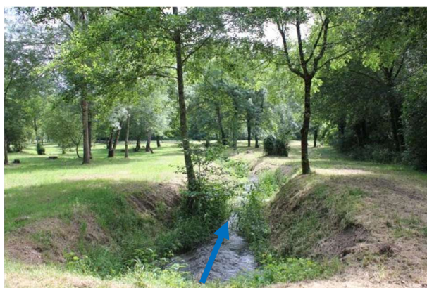
Vue de l'axe 3 en aval immédiat de la buse (Source EGIS date inconnue)
