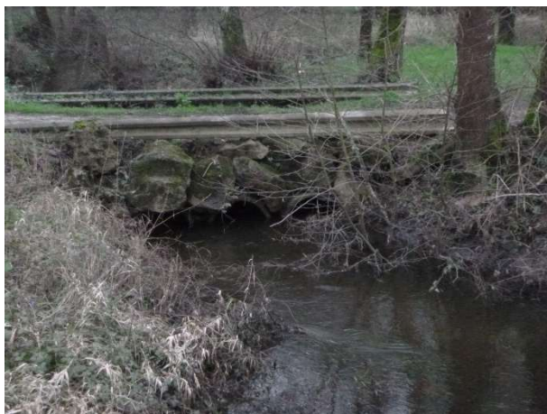
Vue du passage busé depuis l'aval au module (31/01/2018)
