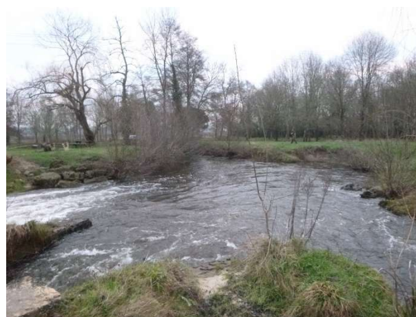
Vue de l'axe 2 à l'aval du seuil (31/01/2018)
