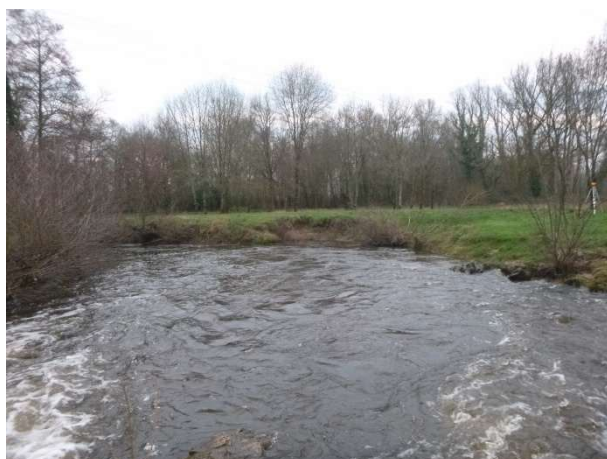
Vue de l'érosion de la berge (31/01/2018)
