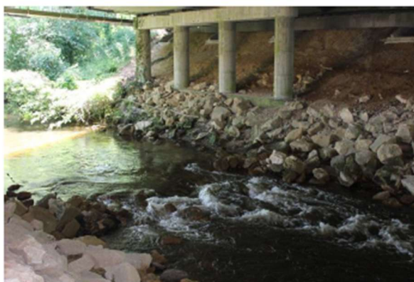
Vue du pont de l'A62 et du seuil en enrochements libres (Source EGIS)
