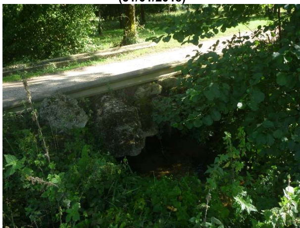
Vue du passage busé depuis l'aval à l'étiage (17/09/2017)
