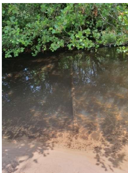
Vue de la conduite traversant l'axe 1 entre le seuil principal et l'ouvrage 3
