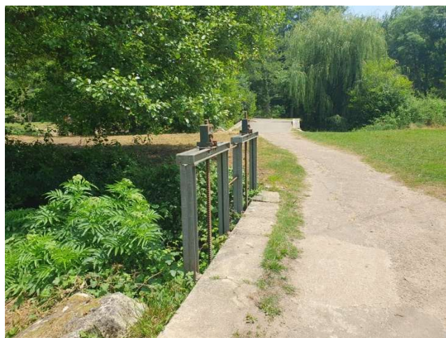
Vue des vannages
