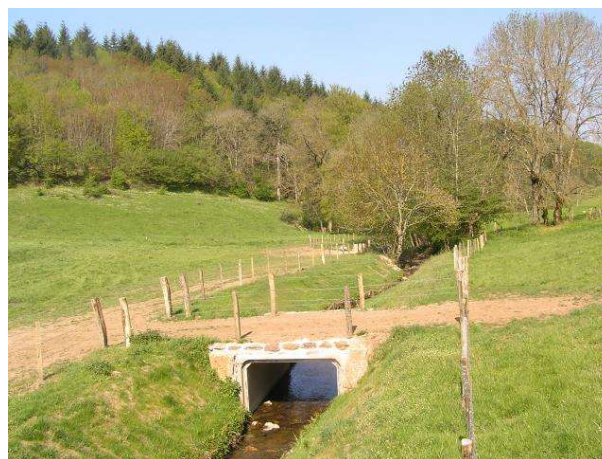
Exemple de réhabilitation d'un passage agricole sur le Trégou dans l'Aveyron (source : CAGR)
