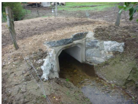
Exemples de dalots calés sous le lit du ruisseau
