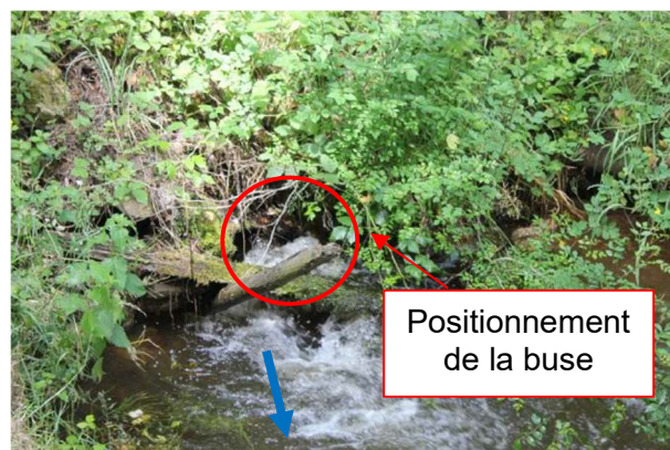
Photographie de la buse sur sa partie aval (Source EGIS date inconnue)
