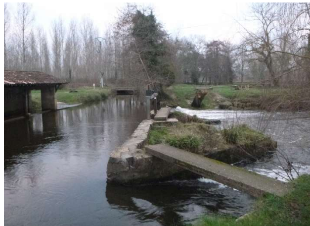
Vue du déversoir rive droite (31/01/2018)
