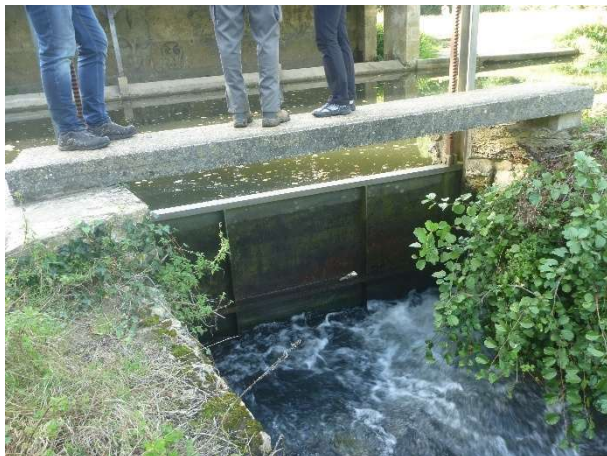
Vue des écoulements en sousverse au niveau de la vanne (17/09/2017)
