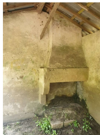
Cheminée interne dans le lavoir
