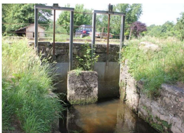
Vue depuis l'aval des vannes de l'axe 1 (Source EGIS date inconnue)
