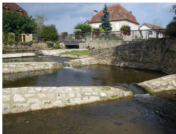
Exemple de seuils en pierres maçonnées.
