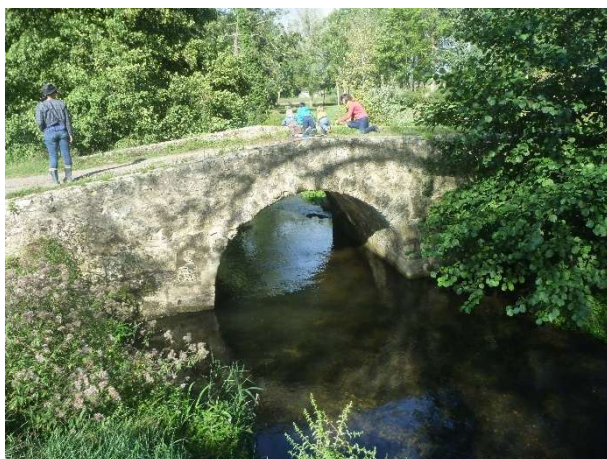
Pont de l'axe 3 (17/09/2017)
