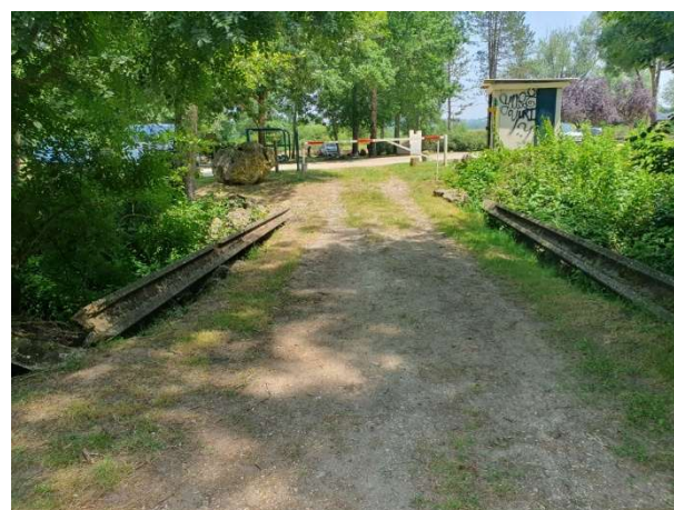
Vue de la voie carrossable (20/06/2025)
