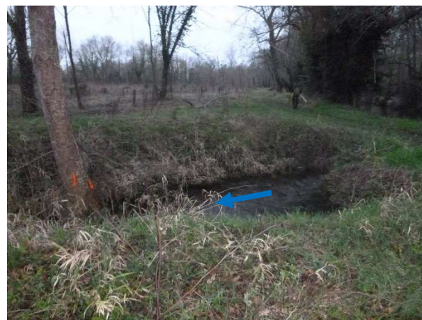
Vue de l'axe 3 en aval immédiat de la buse (31/01/2018)
