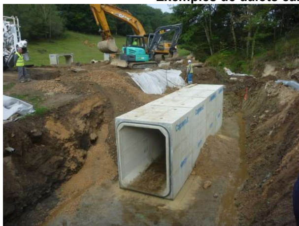
Exemple de dalot calé sous le lit du ruisseau (Photo de gauche : En phase travaux / photo de droite : après travaux)
