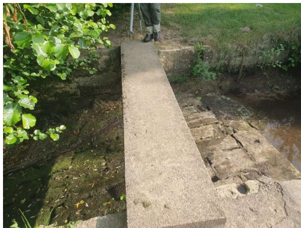
Coursier existant en pierres plates maçonnées
